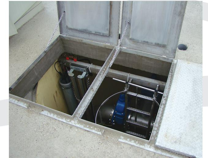
Tlačni cjevovodi su definirani kapacitetom ugrađenih crpki, a spajaju se u jedan, kolektorski, koji izlazi van posude i spaja se na vanjski tlačni cjevovod.
